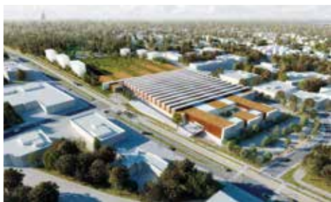
Site de Maintenance et de Remisage (SMR)
