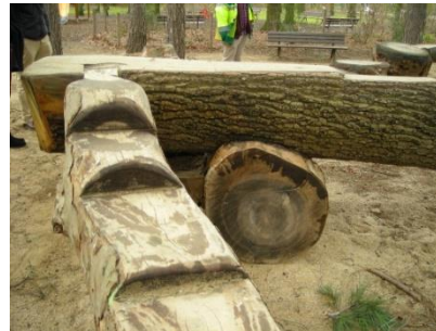
Aire de jeux fabriquée par les bucherons du Bois de Vincennes Liaisons des grumes par tenon mortaise
