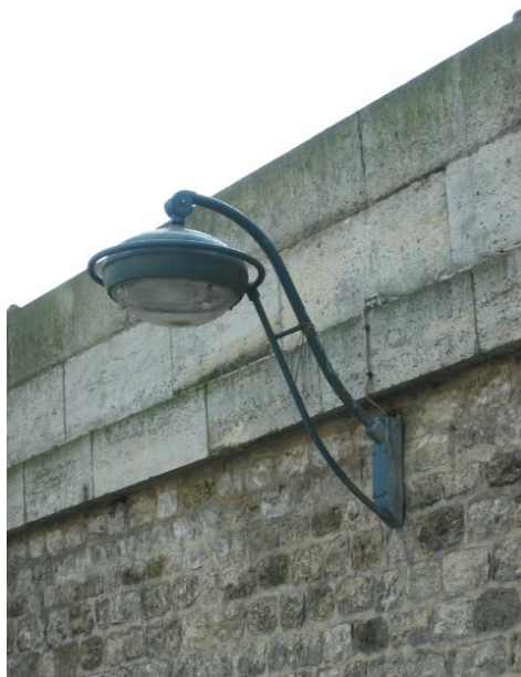
Mobilier éclairage conservé, luminaires leds
