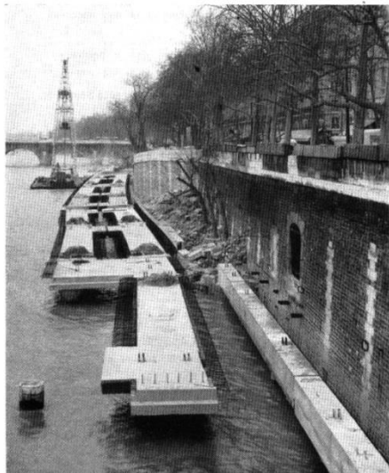
Viaduc - Ossature préfabriquée.
