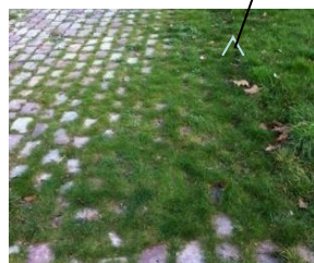
Un sol en pelouse tondue accessible et pavés engazonnés en bord à quai servant d'allée référence de la séquence 8 réalisée en 2012
