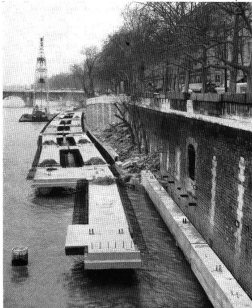
Viaduc - Ossature préfabriquée.
