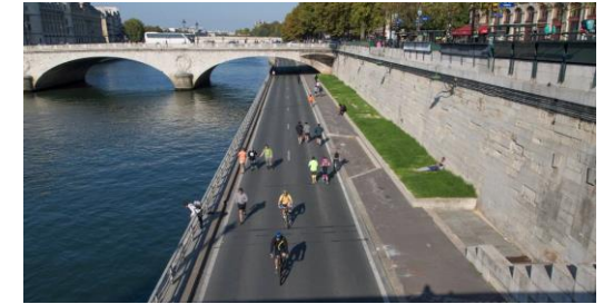
Mur actuel entre le pont au Change et le pont Notre-Dame 80m de long - 5 m de haut - exposition plein Sud
