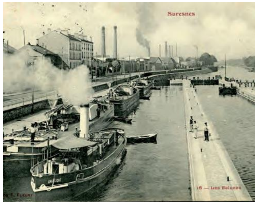
Ecluses barrage de Suresnes quelques années après son achèvement en 1869
