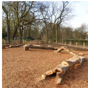
Aire de jeux fabriquée par les bucherons du Bois de Vincennes Liaisons des grumes par tenon mortaise
