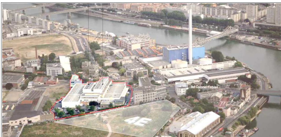
Les imprimeries dans leur environnement actuel – source : étude d'impact
