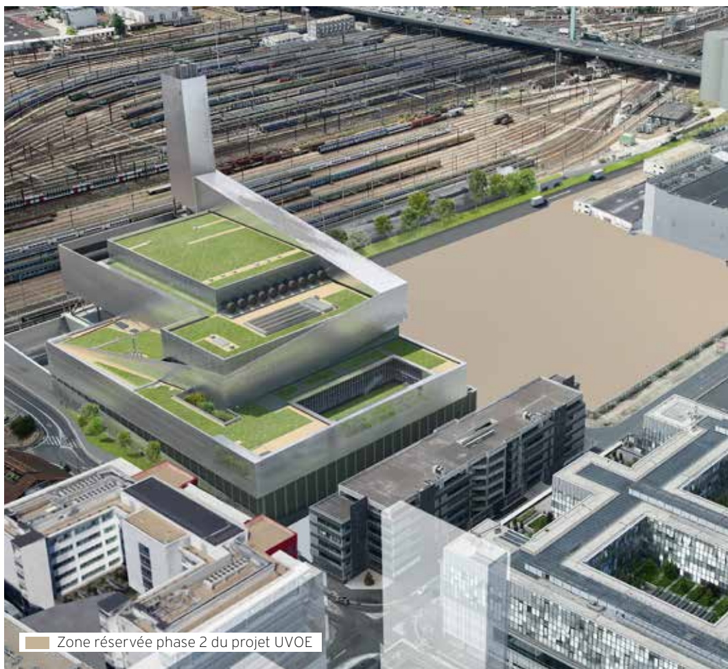
Vue sur les toitures végétalisées de l'UVE
